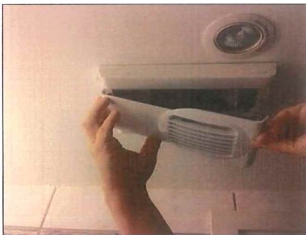
1. Ta ned ventilasjonsdekslet for vask
